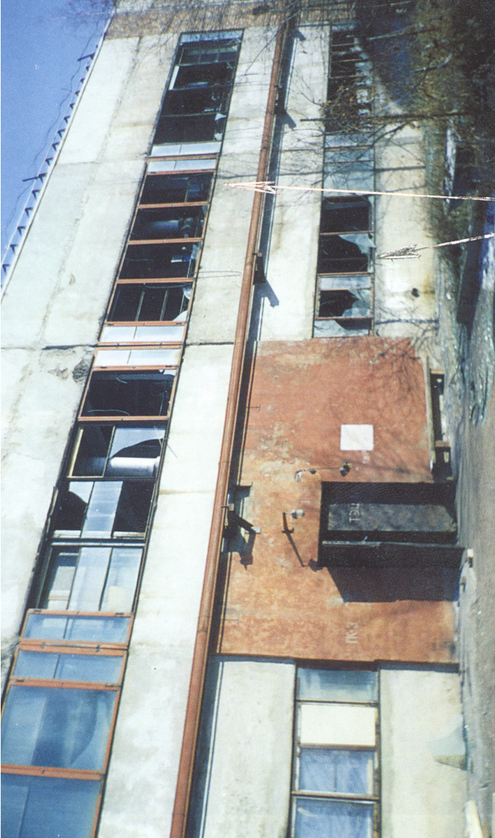
Рис. 1.13. Взрыв газа в топке котельной на ООО «Братский кирпичный завод» в г.Братске 19.10.02
